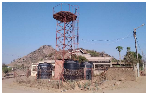
Sistema de abastecimento de água da HCB no bairro Unidade
