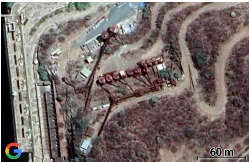
Figura 5-38 - HCB- vestígios das infraestruturas da época da construção da barragem
