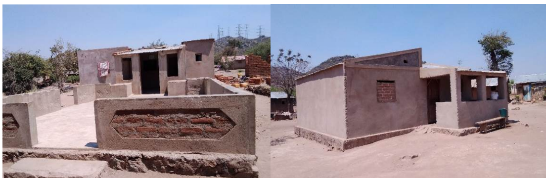
Casas feitas de material convencional
