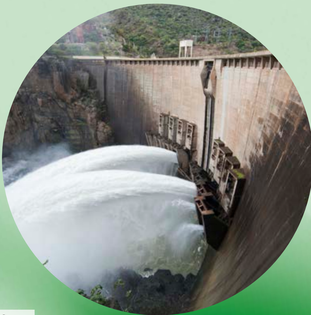
Vista Lateral da Barragem
