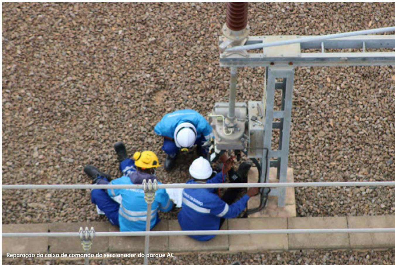
Reparação da caixa de comando do seccionador do parque AC
