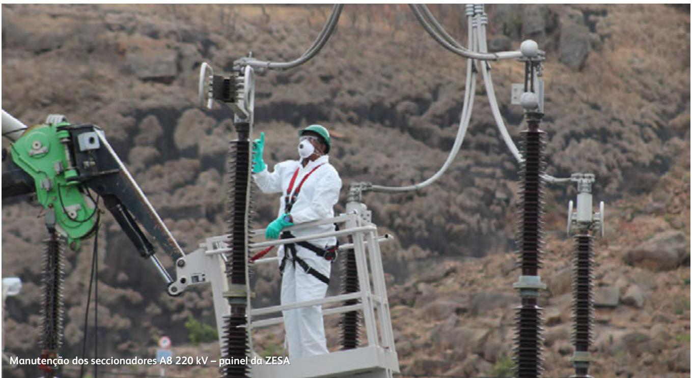
Manutenção dos seccionadores A8 220 kV – painel da ZESA
