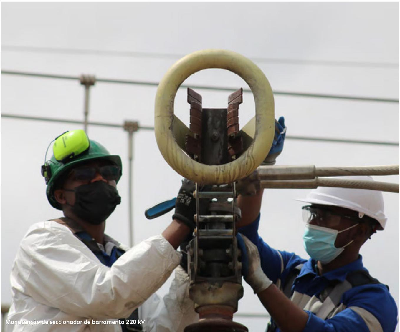
Manutenção de seccionador de barramento 220 kV
