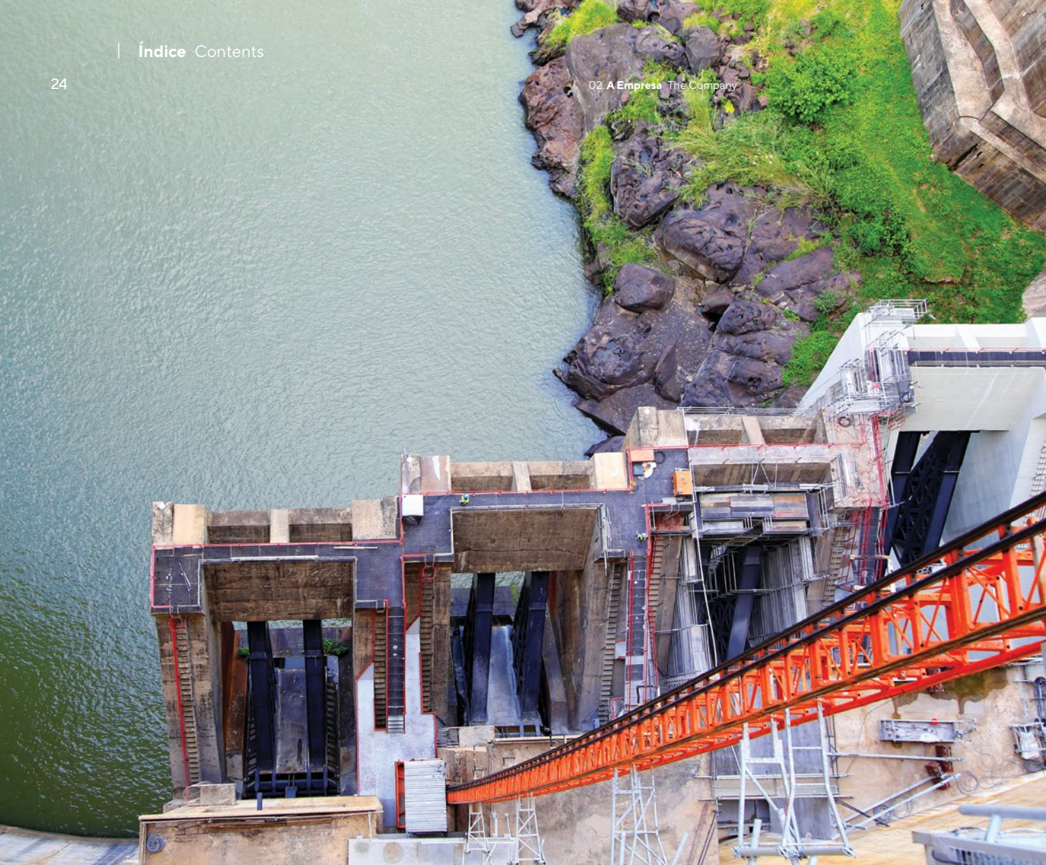
Vista parcial dos descarregadores Partial view of spillways
