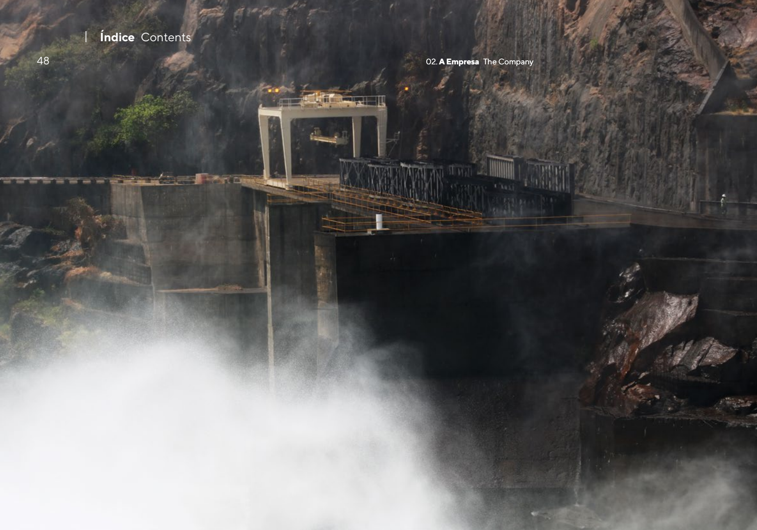
Vista parcial dos descarregadores de restituição Partial view of tailrace spillways
