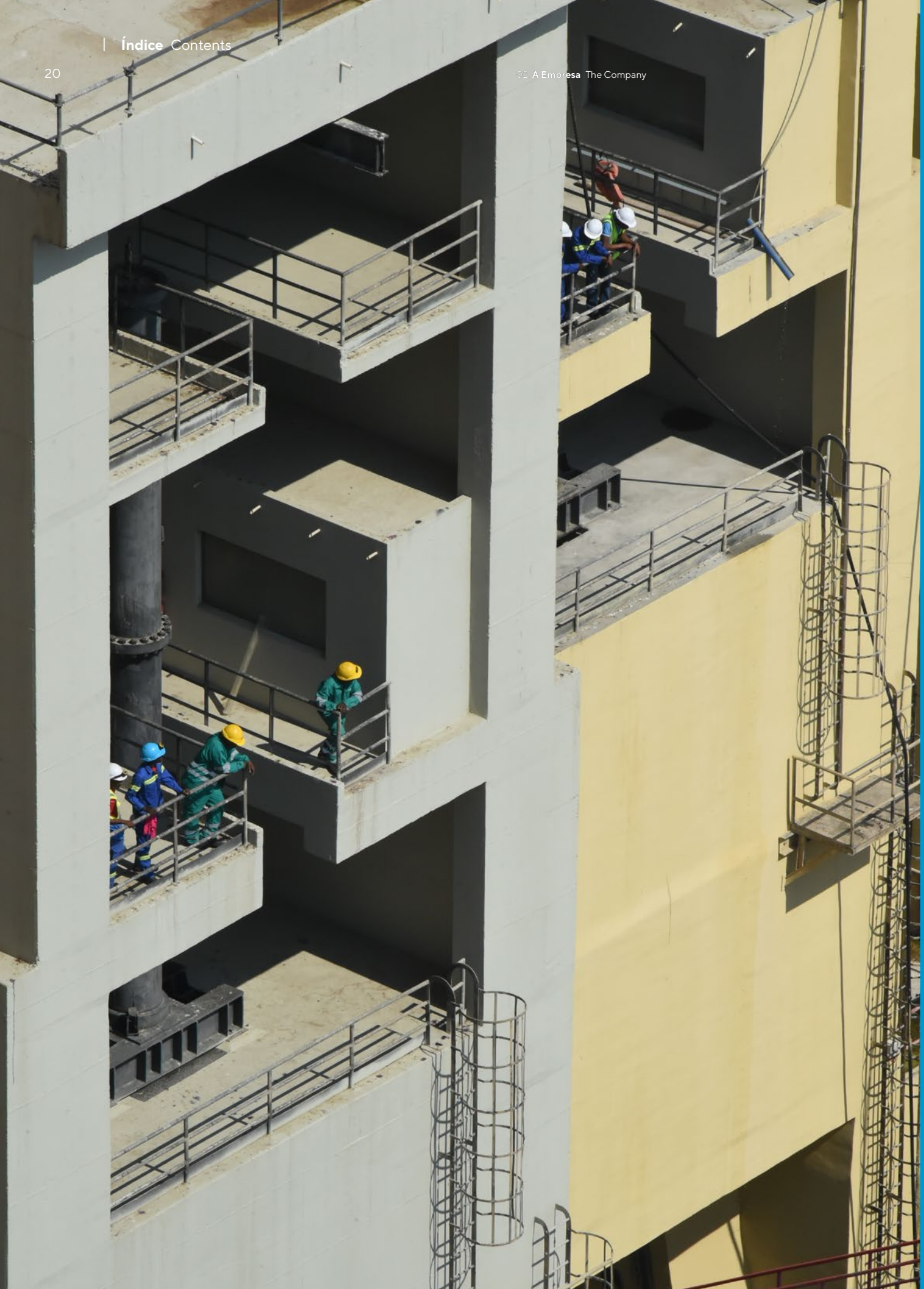
Vista parcial das varandas dos descarregadores de meio fundo Partial view of mid-height spillway balconies
