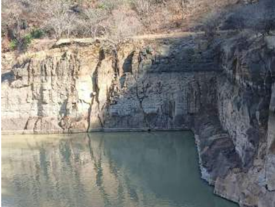
Figura 2-6. Perfil rochoso inconsistente na tomada de água da CBN
