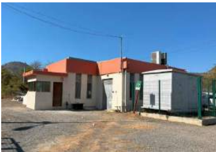
Figura 7. Vista do Local C
