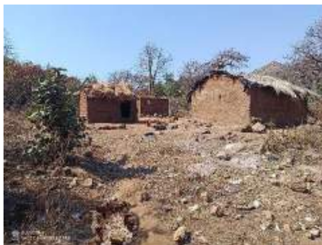
Figura 5-3: Risco de eroão (erosão laminar)
