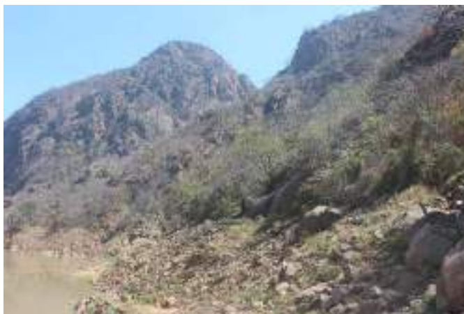
Figura 4-3: Vista panorâmica do local da observação CBN-2
