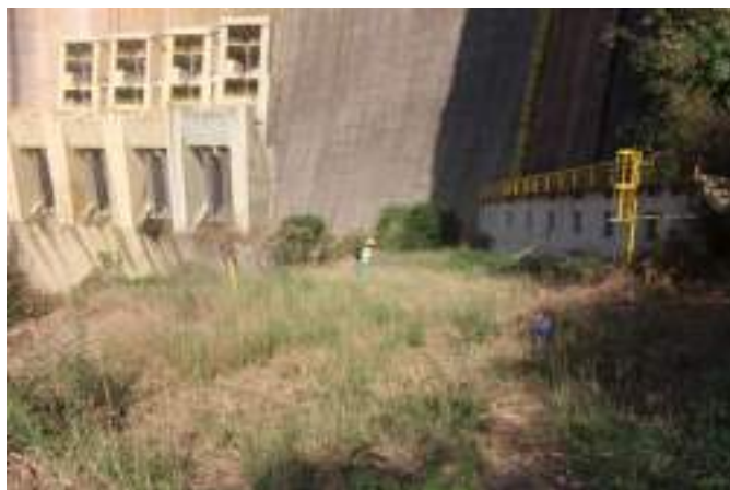
Figura 4-5: Vista panorâmica do local da observação CBN - 3
