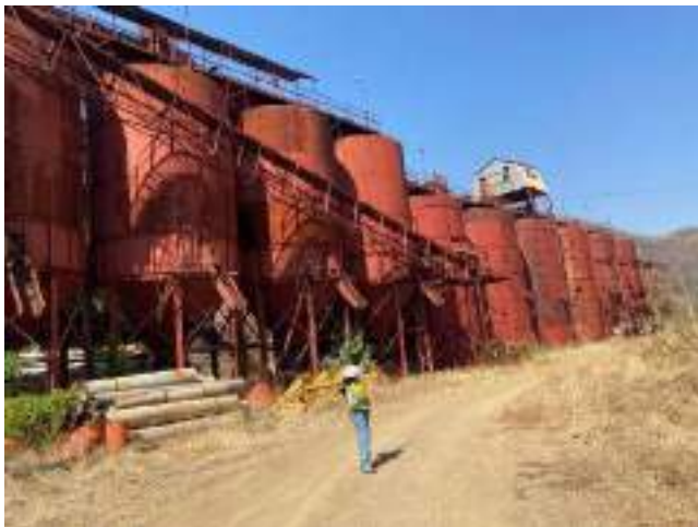
Figura 8 – Silos usados na produção de betão para a construção da Barragem Central Sul
