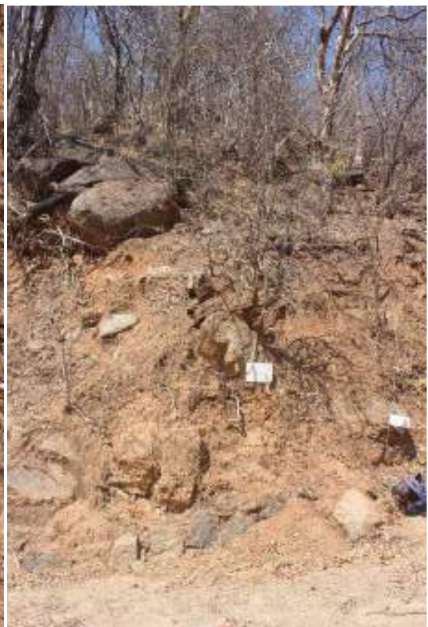
Figura 3-6: Vista panorâmica do Barranco
