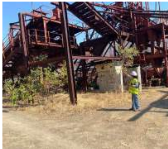
Figura 9 – Estrutura metálica do estaleiro de construção da barragem
