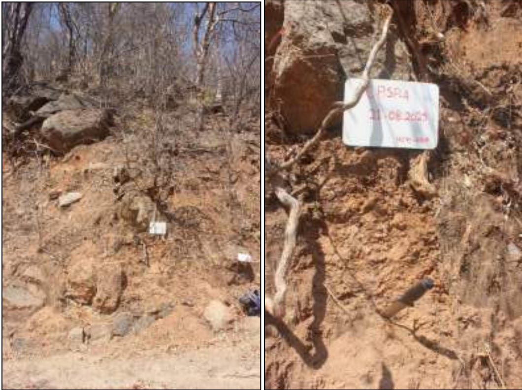
Figura 10-15: Barranco do Acesso à Pedreira (à Esquerda) e Vista Panorâmica do Barranco (à Direita)
