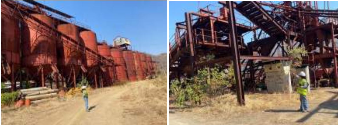
Figura 11-17: Silos (produção de betão) para a construção da CBS (à esquerda) e Estrutura Metálica do Estaleiro (à direita)
