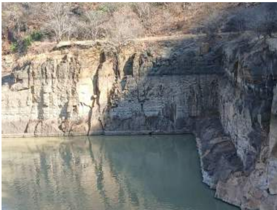
Figura 10-8: Perfil Rochoso Inconsistente na Tomada de Água da CBN
