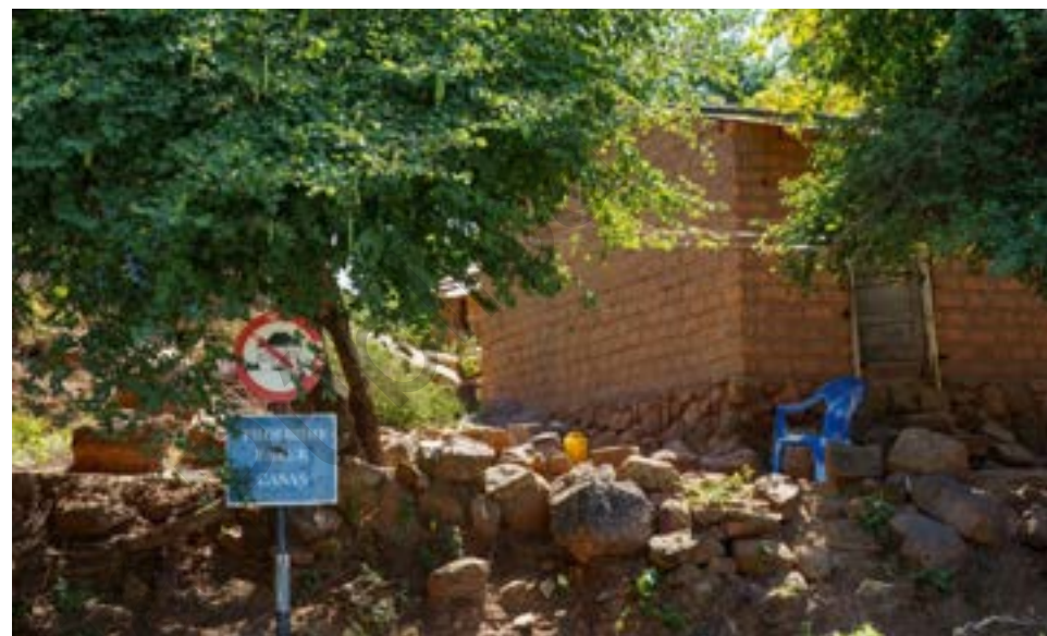
38. Casa construída na área proibida, junto a placa de proibição de construções, Acampamento Africano.
