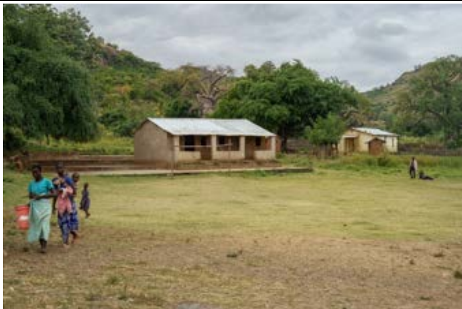
37. Escola primária desactivada no Acampamento Africano.
